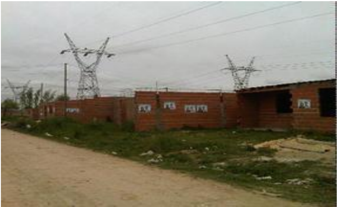
Las redes de Alta Tensión y los nuevos barrios
