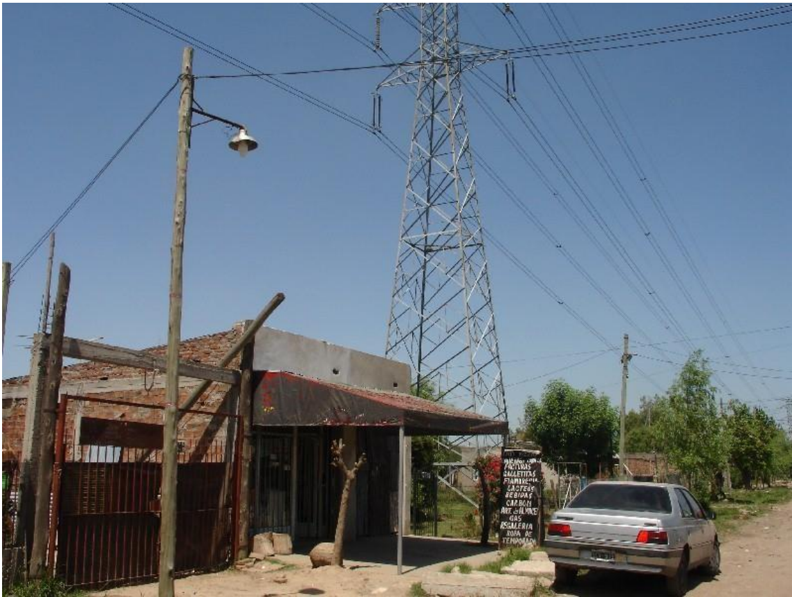
Las redes de Alta Tensión y los nuevos barrios
